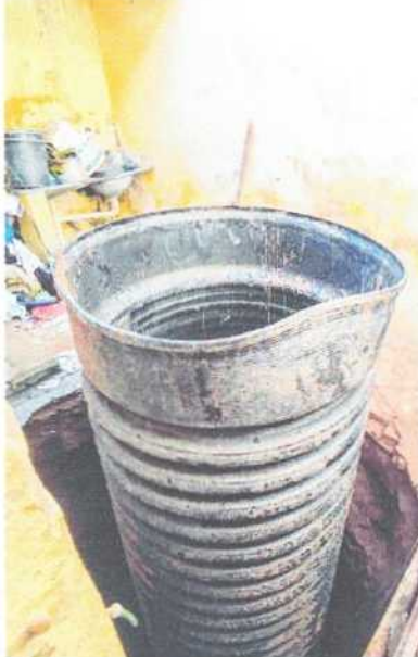
UMA MANILHA foi instalada no local para ajudar no resgate |
