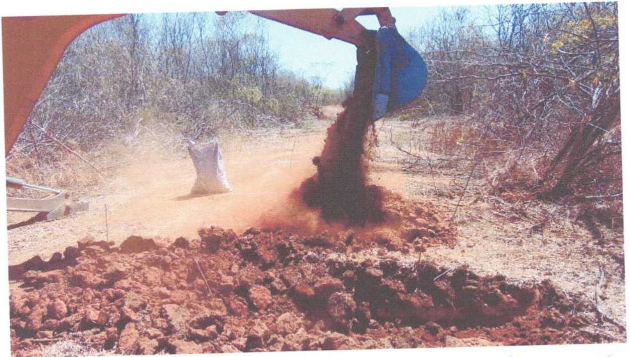
Figura 2 – Jazida de Solo
