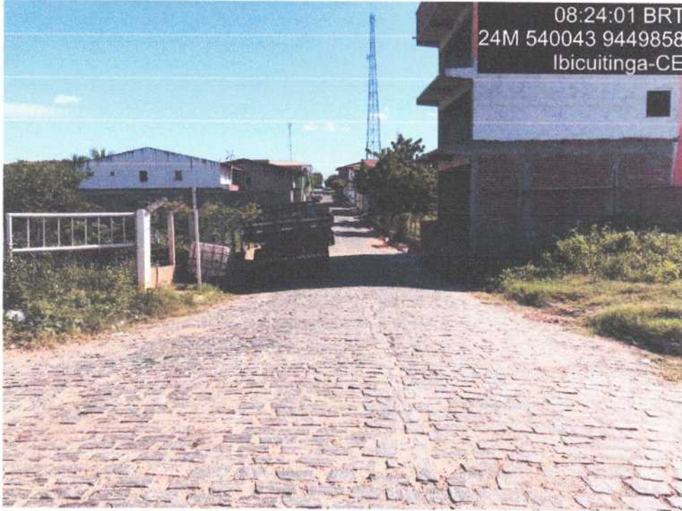
Figura 7 – Rua CICERO BENTO FERNANDES (INICIO)
