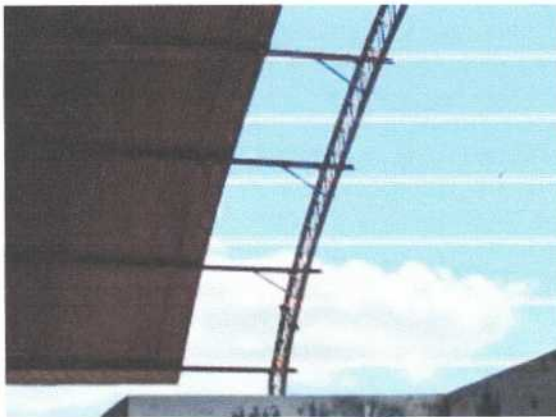
ESTRUTURA DA COBERTA
