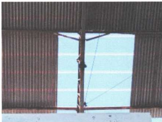
ESTRUTURA DA COBERTA
